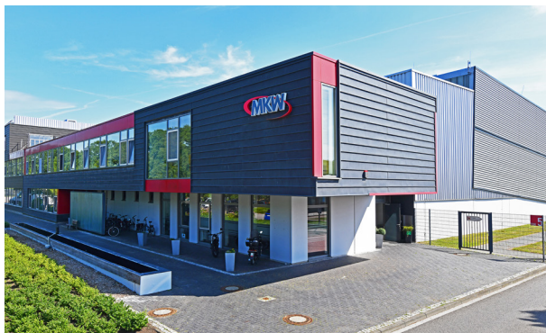
Verwaltungsgebäude der MKW in Großefehn.
